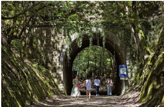
Figura 29 | Túnel da Ecopista do Vouga
