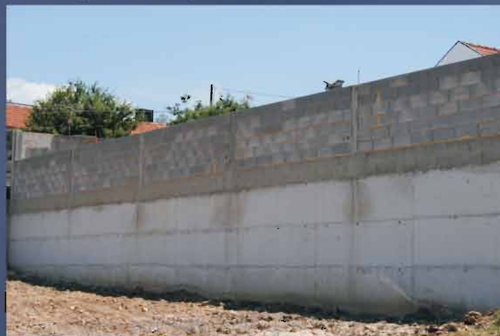
10- Execução de muro de contenção de terras na Sede do Grupo Folclórico e Etnográfico de Albergaria-a-Velha
