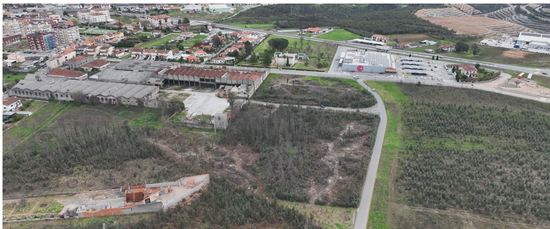
Figura 6 – Imagem geral dos terrenos expectantes na Rua Brandão Gomes e na Rua Comendador Martins Pereira
