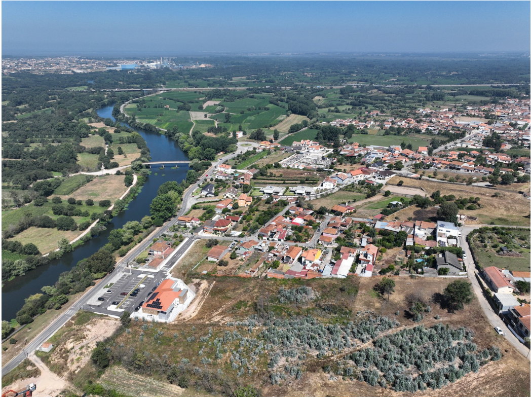
Figura 3 – Vista Geral com o local onde se pretende a alteração
