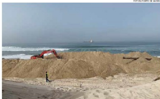
Trabalhos em curso que contribuirão para o reforço do cordão dunar
