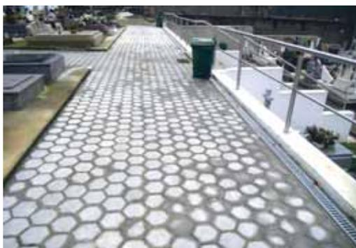
Execução do pavimento central, águas pluviais e corrimões na parte nova do Cemitério de Ribeira de Fraguas
